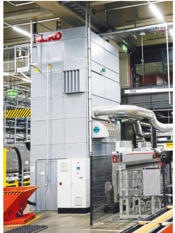
Für den Brand- und Explosionsschutz wurde eine Löschleitung verlegt und eine Q-Box installiert
