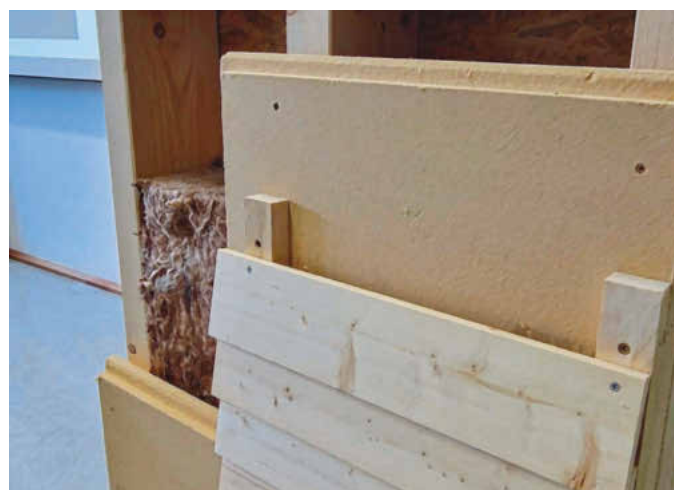
Ein 1:1-Modell veranschaulicht den für das Tiny-House vorgesehenen Wandaufbau
