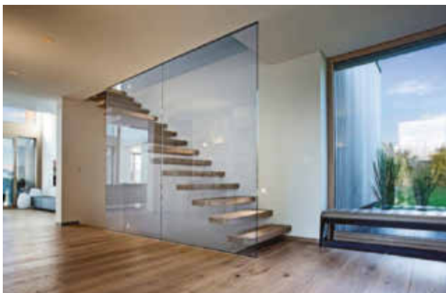
Die Festverglasung neben der Treppe wurde mit Hebehilfe von außen montiert
