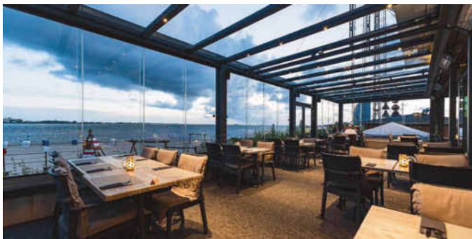
Glasdach in Windlastzone 4: Hersteller TS-Aluminium hat den ausführenden Betrieb Mahrenholz bei der Statikberechnung unterstützt
